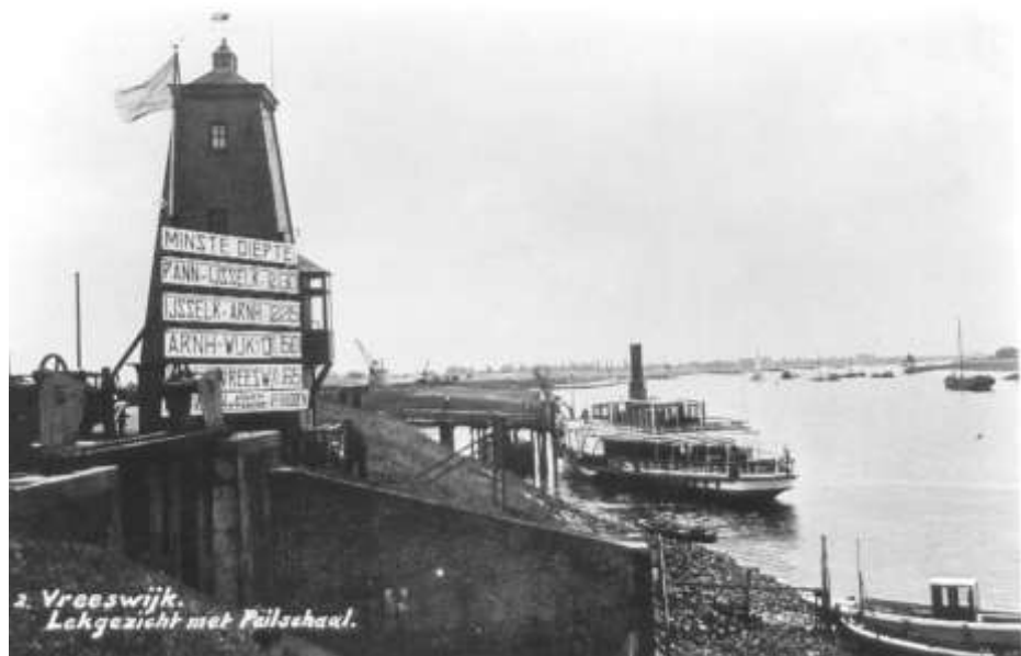
Figuur 35: Rijkspeilschaal, met steiger van de Kuilenburgse boot. Net niet meer in beeld of op het moment van de foto niet meer aanwezig, rechts van de fotograaf, de plaats van de steiger van "Concordia".
