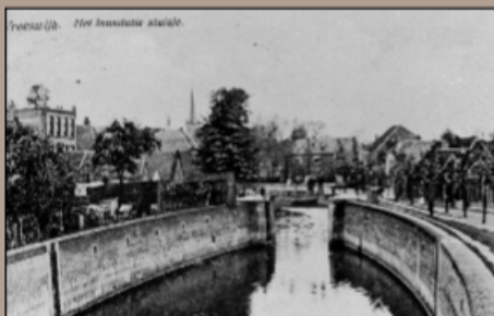
[1921] Het inundatiesluisje in Vreeswijk
