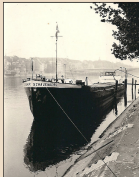
[1968] Ms Schauenburg van de rederij Silag AG te Basel. Laadvermogen 999 ton; afmetingen 78,4 x 8,53 meter; 2x 300pk Sulzer motoren; bouwjaar 1948
