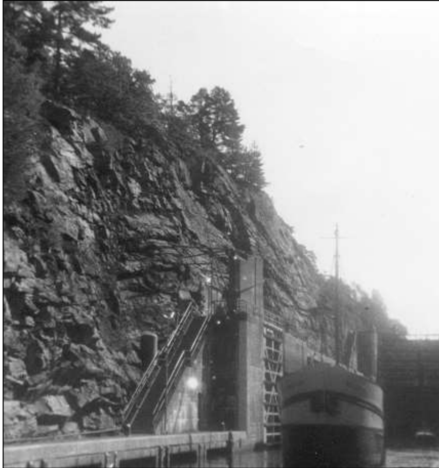
Sluizen Trohättan kanaal, 1968
