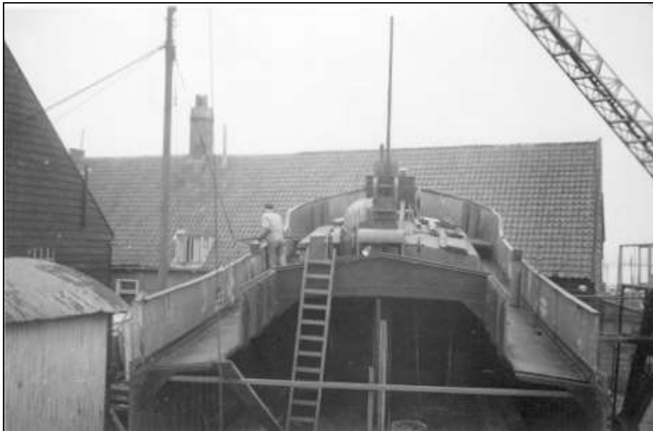
Voorschip los van achterschip, om het schip te verlengen. Puttershoek, 1952
