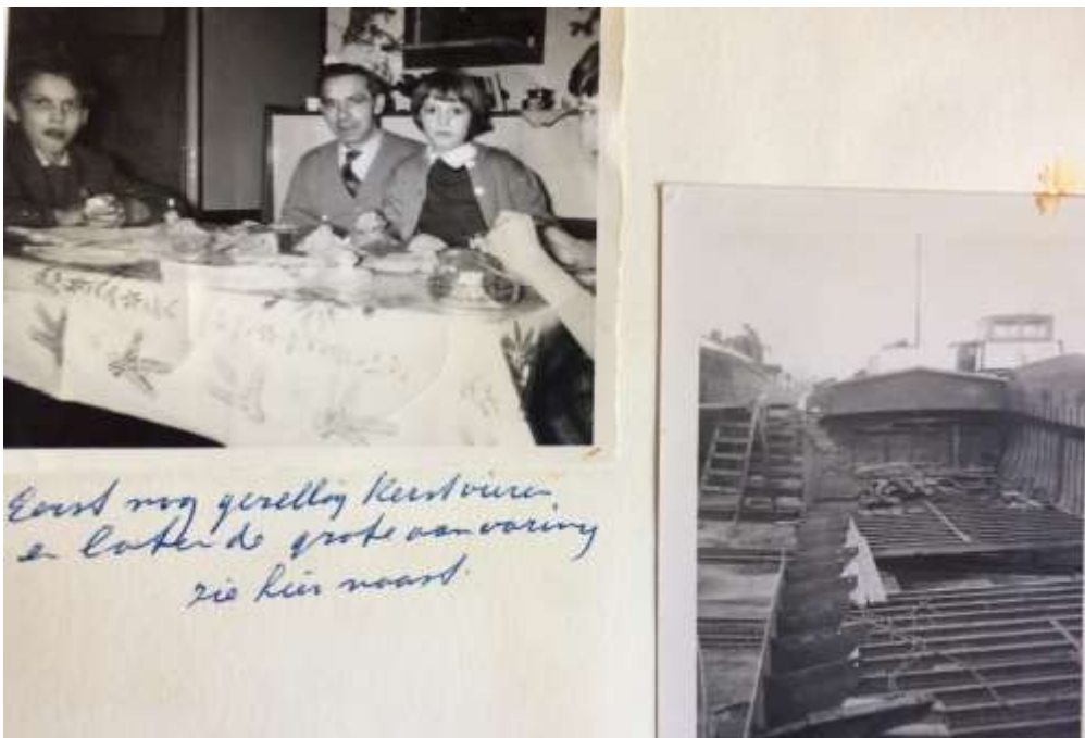
Foto rechts: schade na de aanvaring met de Largo
